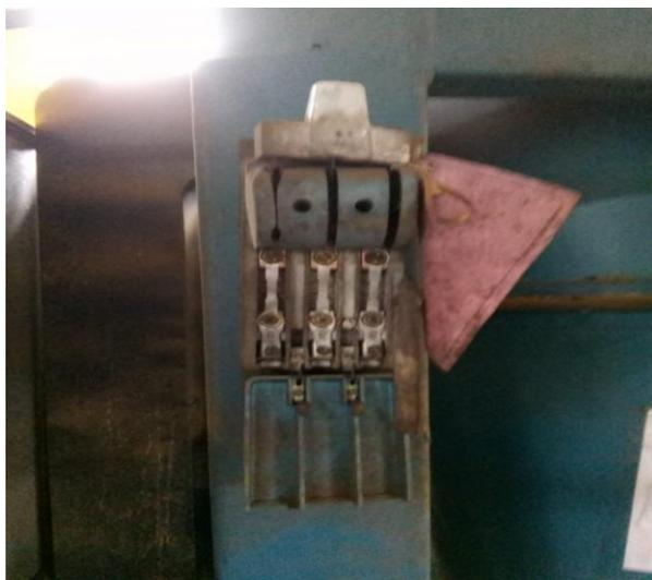
**Figura 23.** Interruptor tipo cuchilla de tres polos
