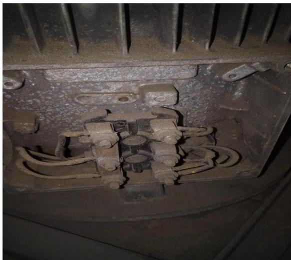
**Figura 20.** Bornera de conexiones
