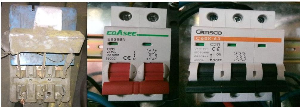
**Figura 32.** Breaker del circuito de control y fuerza
