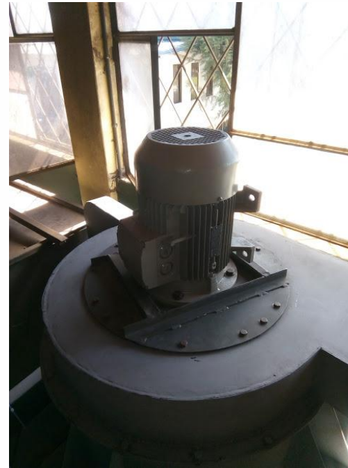
MONTAJE DEL MOTOR
