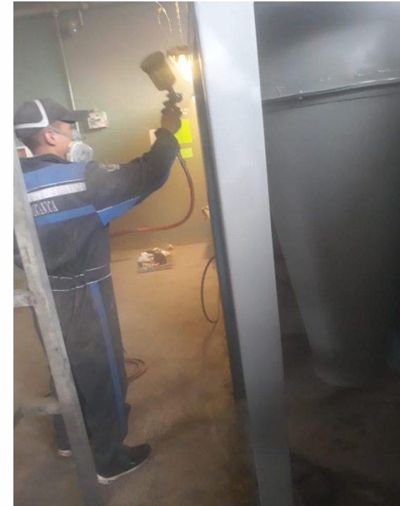
PINTADO DE ESTRUCTURA
