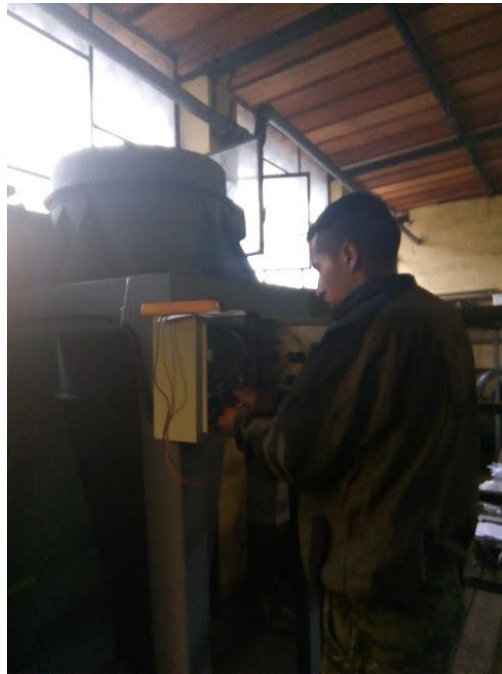
COLOCACIÓN DE PANEL DE CONTROL
