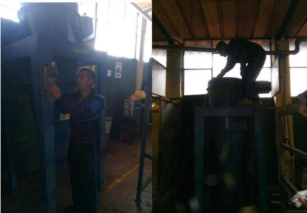
LIJADO DE ESTRUCTURA
