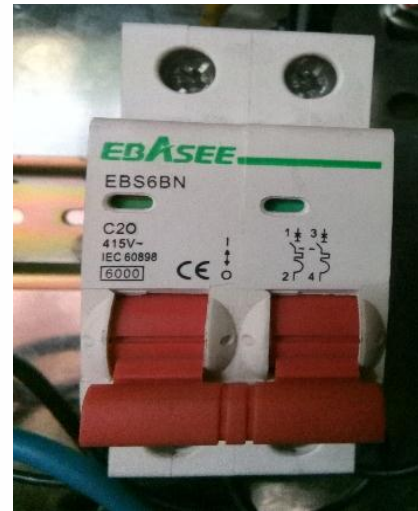
COLOCACIÓN DE BREAKER DEL CIRCUITO DE CONTROL
