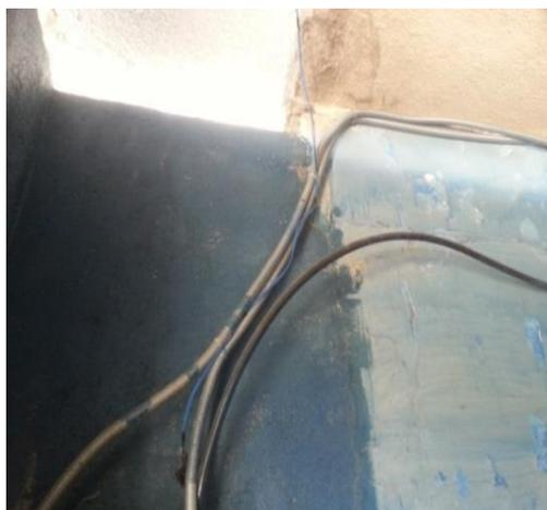
**Figura 16.** Cableado eléctrico se encuentra a la intemperie
