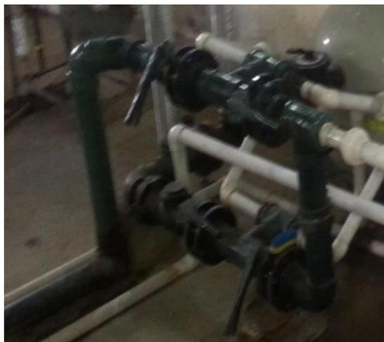
**Figura 12.**Válvula Selectora
