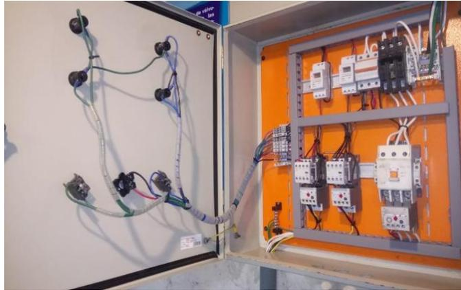
**Figura 40.** Tablero eléctrico finalizado vista interior
