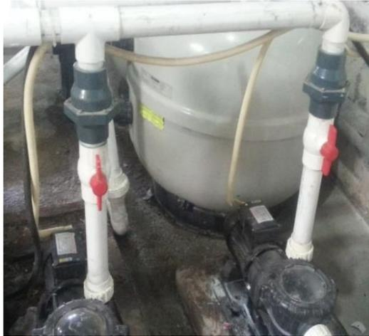
**Figura 17.** Condutores de las bombas sin ninguna protección
