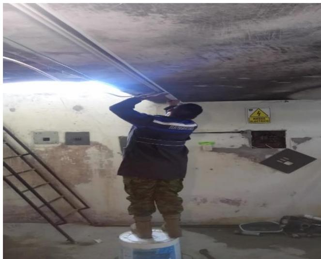
**Figura 42.** *Colocación de conductores por medio de canaletas*
