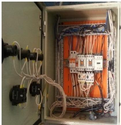
**Figura 22.** Tablero eléctrico de bombas de agua
