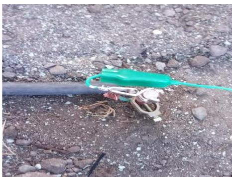
**Figura 50.** Conexión del conductor con el electrodo
