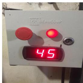
**Figura 30.** Tablero eléctrico de control de temperatura
