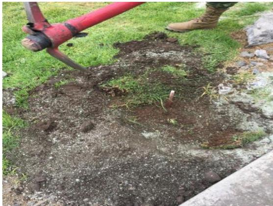
**Figura 49.** Preparación del terreno y puesta de electrodo
