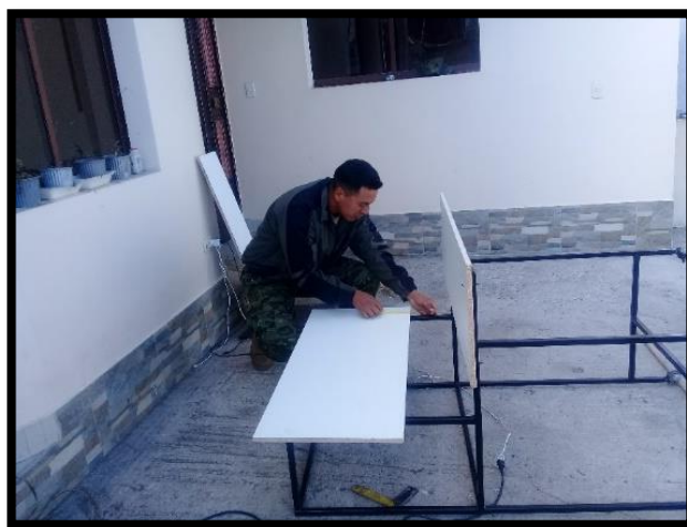
Figura 27. Colocación de melamínicos
