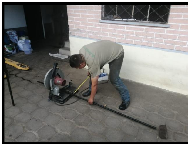
Figura 24. Medición y corte de tubos cuadrado
