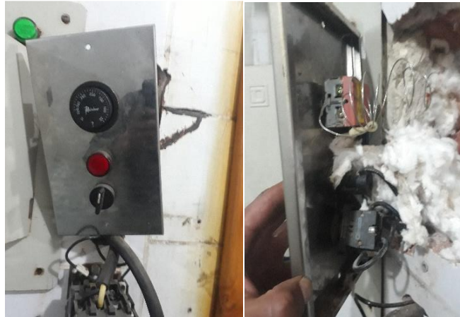
Figura 28. Sistema de control de las resistencias térmicas
