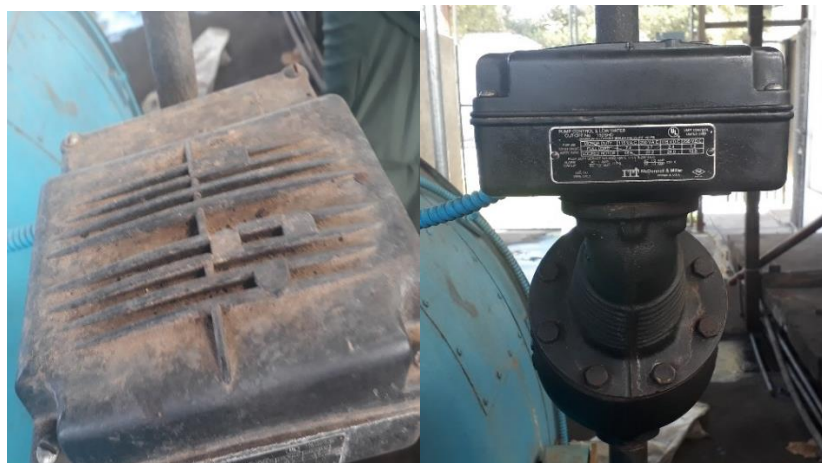
Figura 22. Limpieza de la estructura del caldero
