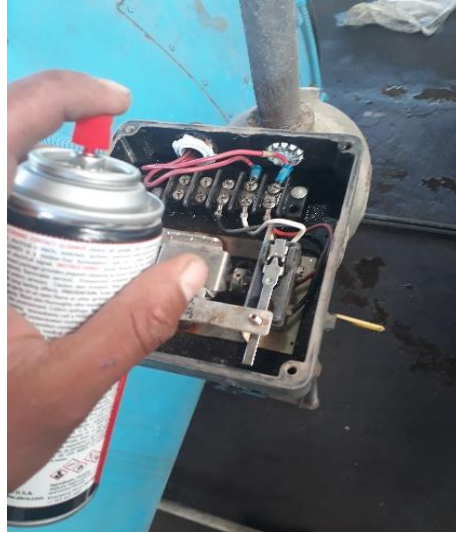
Figura 23. Limpieza de contactos
