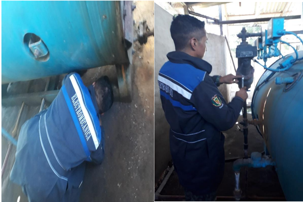
Figura 17. Desmontaje de la estructura del caldero
