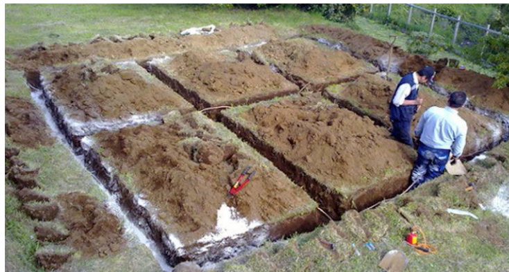
Figura 11. Puesta de Una Malla a Tierra
