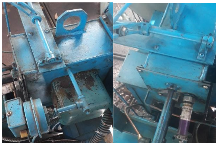
Figura 20. Limpieza de la Estructura del caldero (CARCASA)
