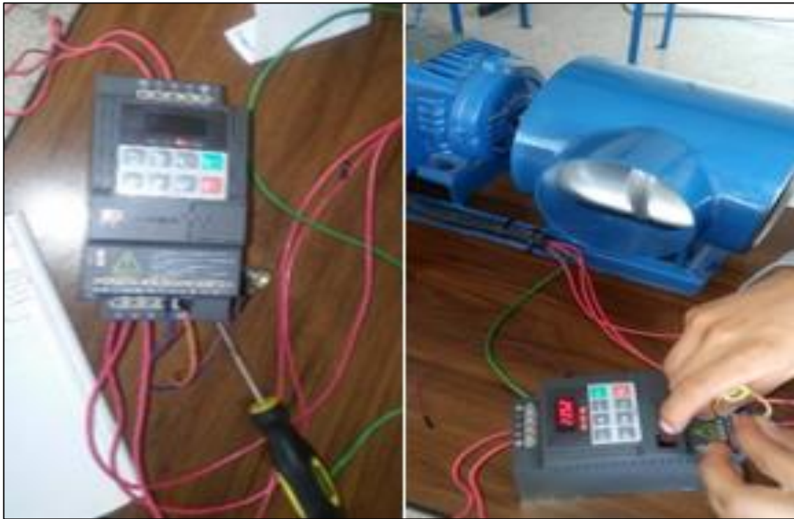
Figura 141. Prueba de la programación del variador de frecuencia.
