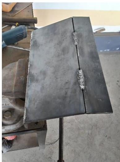
*Figura 30* .Soldadura de placas metálicas para base
