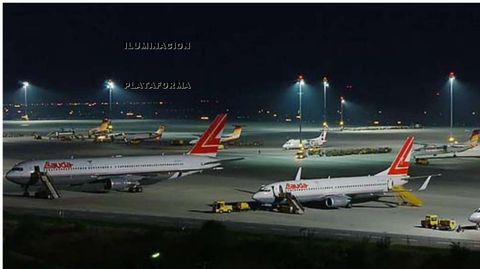
Figura 2.22: Iluminación de plataforma con proyectores.
