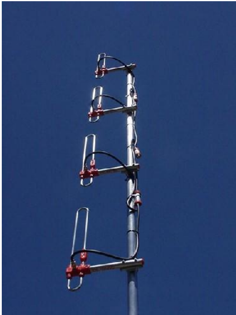
Figura 3.1 Antena de 4 dipolos similar a la que se encuentra instalada en la Loma Achande.
