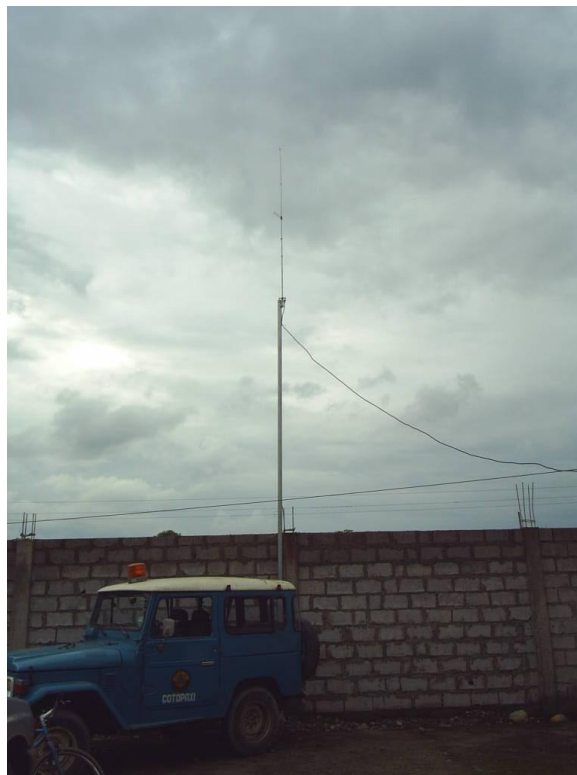
Figura 3.6 Antena Ringo Ranger ARX-2B instalada en la Junta provincial de La Maná
