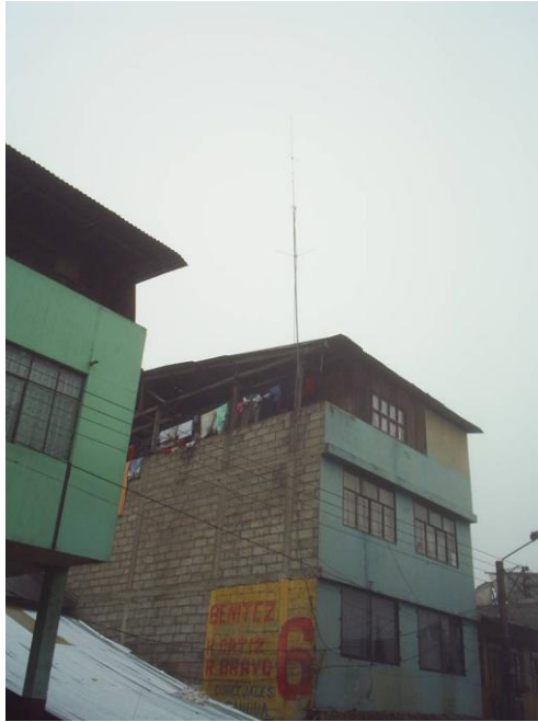
Figura 3.3 Antena Ringo Ranger ARX – 2B Colocada en “El Corazón”
