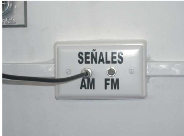
Foto. 3.28. Instalación de conectores BNC y señalética
