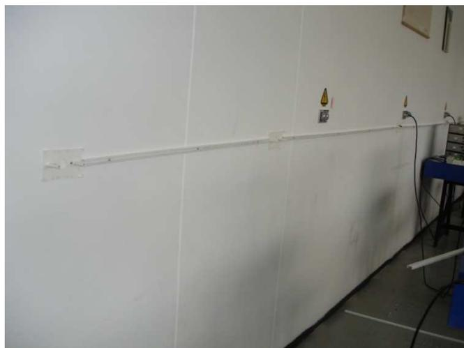
Foto. 3.27. Instalación de canaletas y cajetines
