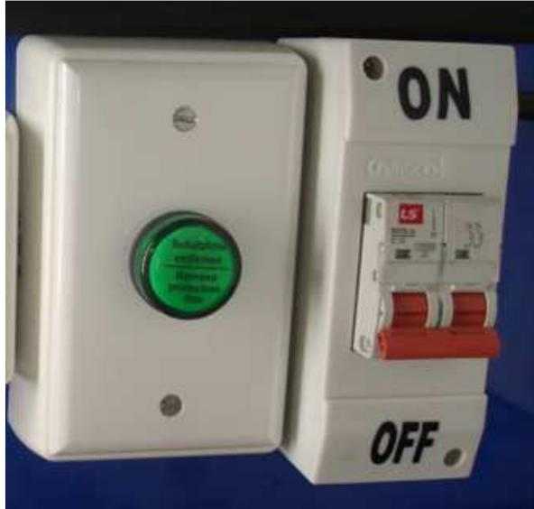
Foto. 3.7. Instalación de luz piloto
