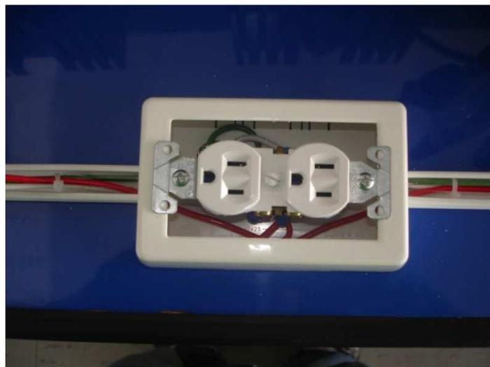
Foto. 3.8. Instalación de los tomacorrientes con los terminales
