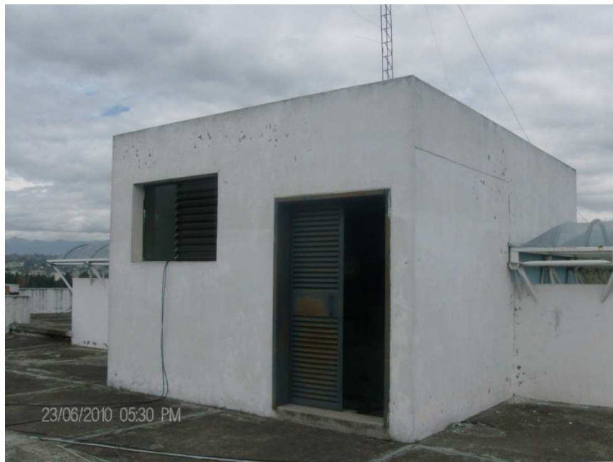
Foto 3.27 Cuarto de máquinas en donde se encuentran los equipos
