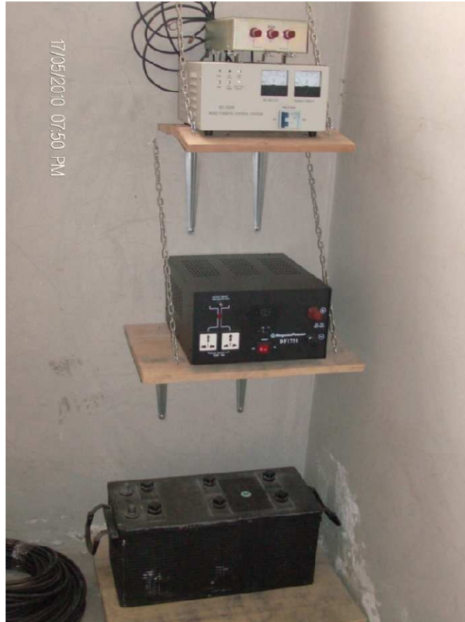
Foto 3.26 Armado y ubicación de los equipos
