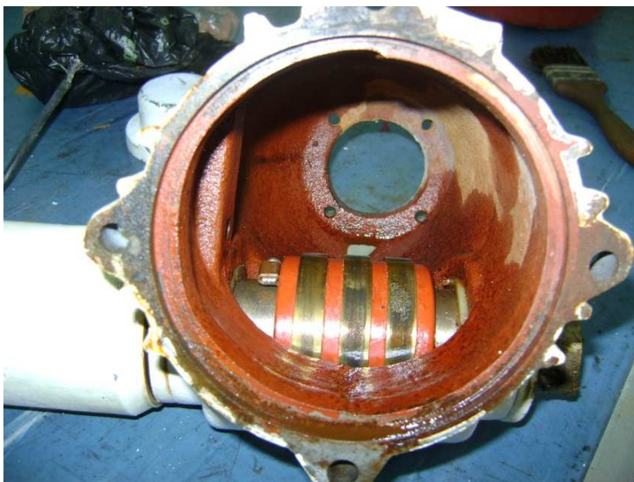
Foto 3.1 Parte interna del aerogenerador con agua
