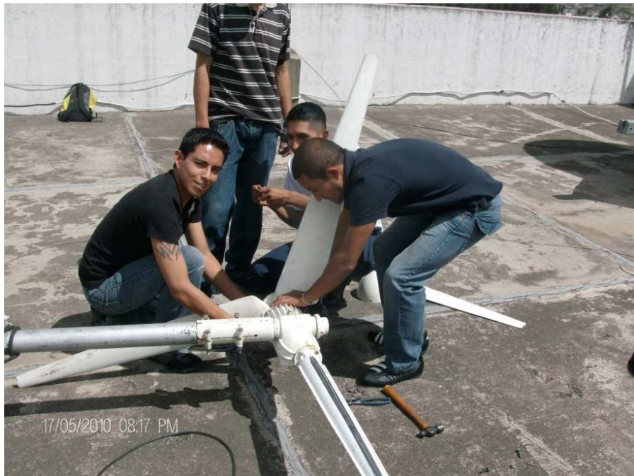
Foto 3.11 Armado del aerogenerador
