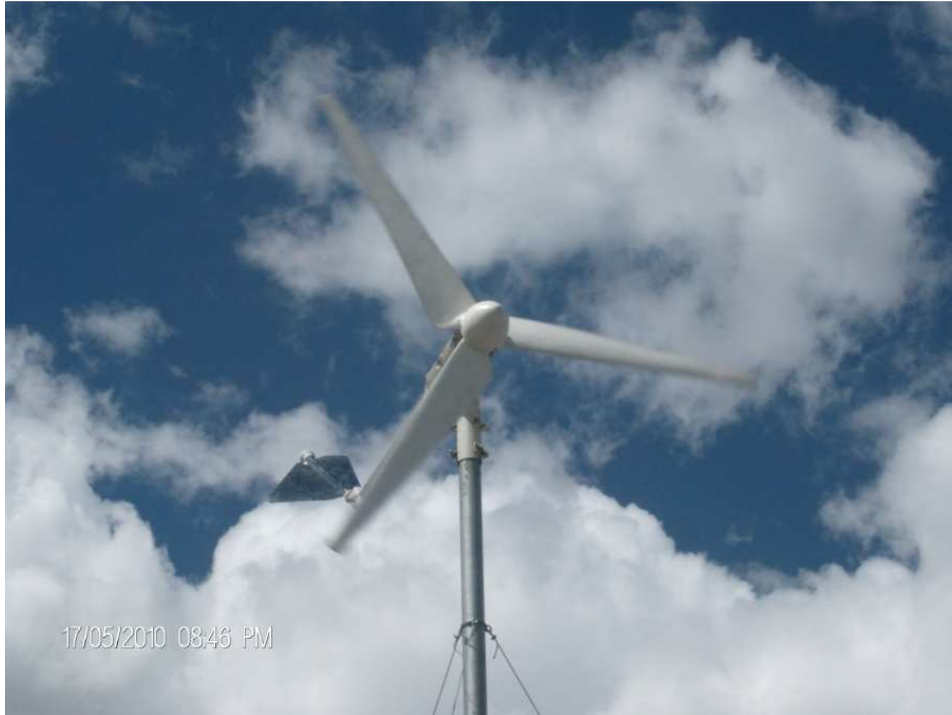
Foto 3.14 Funcionamiento del aerogenerador en la terraza del ITSA
