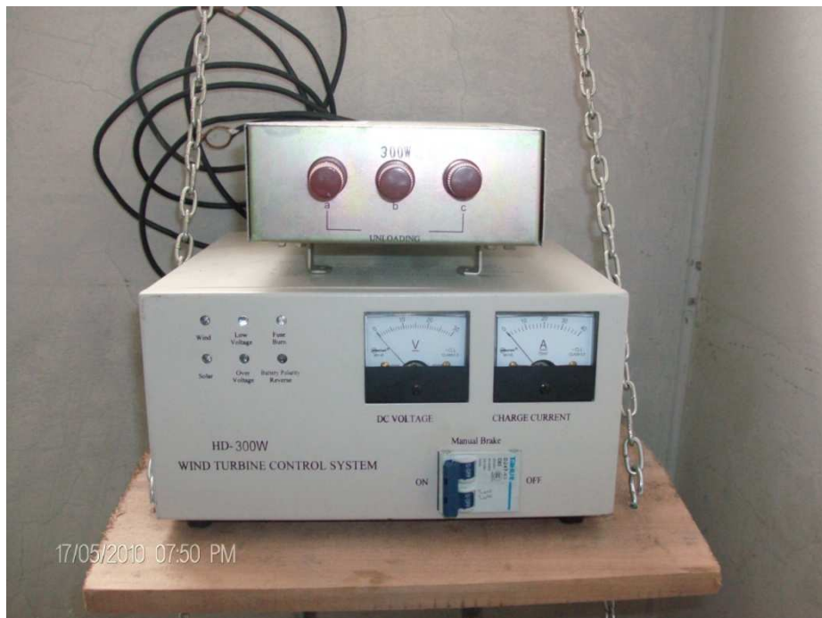
Foto 3.23 Armado y ubicación de los equipos
