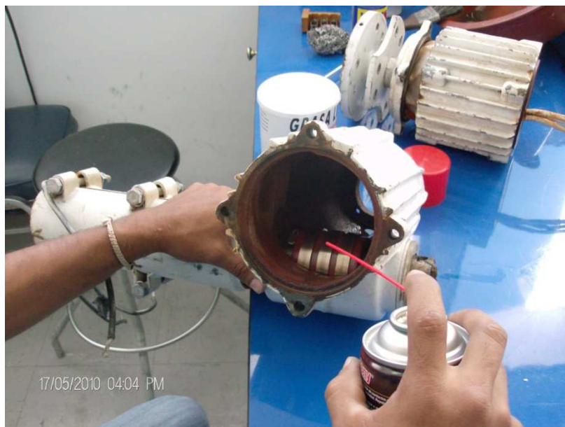
Foto 3.5 Limpieza de la parte interna del aerogenerador
