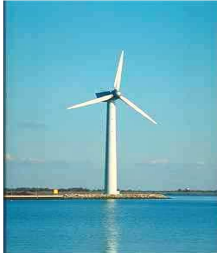
Figura 2.4 Aerogenerador de tres palas
