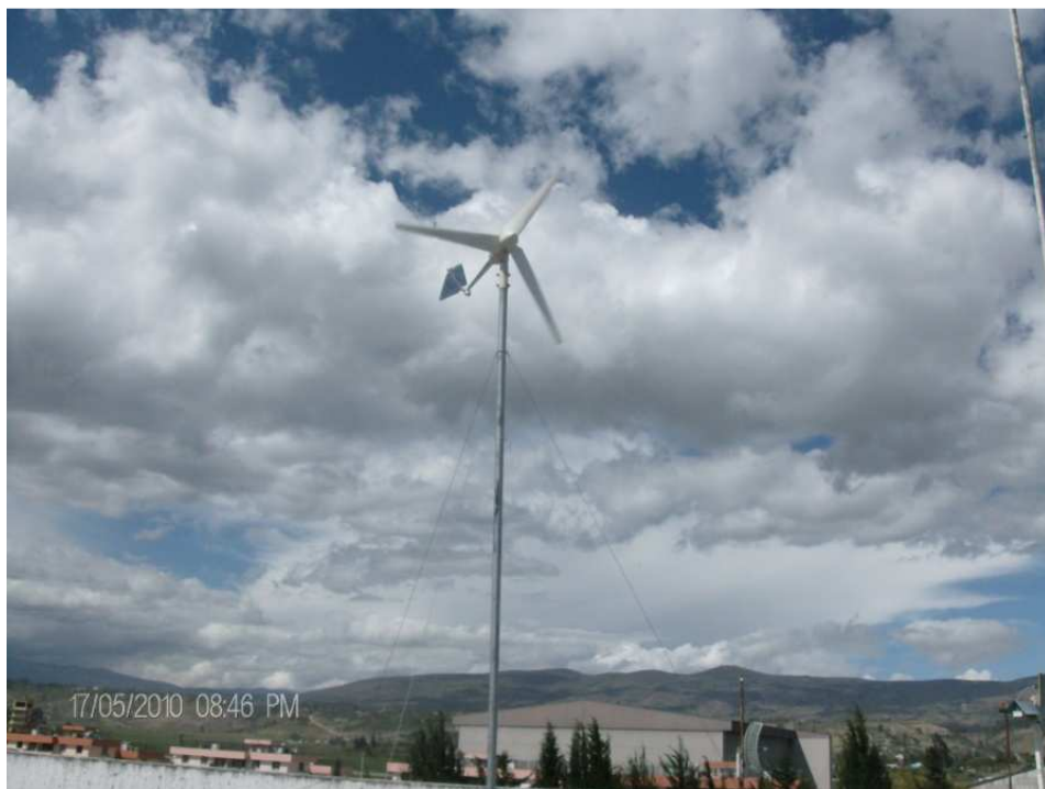
Foto 3.13 Instalación del aerogenerador en la terraza del ITSA
