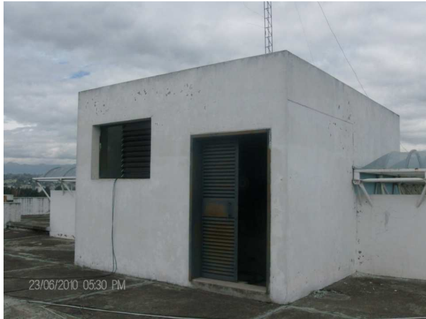
Foto 3.29 Cuarto de máquinas de donde sale en cableado
