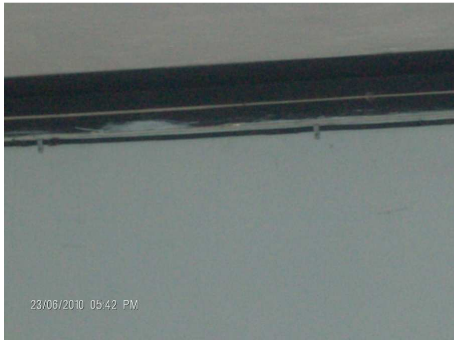
Foto 3.33 Cableado que va del breaker a la otra puerta automática ITSA
