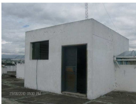
Foto 3.35 Cuarto de máquinas de donde sale en cableado
