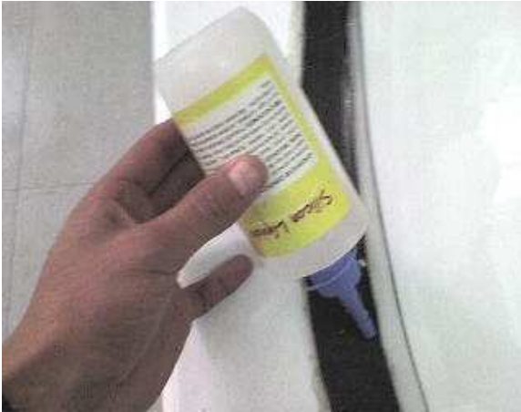
Foto 14. Puesta de silicona en los orificios
