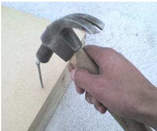
Foto 2. Clavado de listones con tablero
