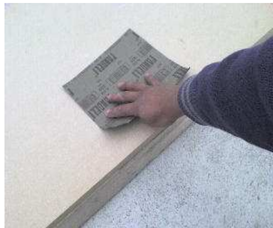
Foto 3. Lijado del tablero base
