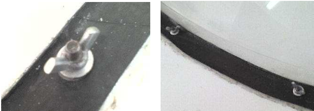
Foto 13. Ubicación de los pernos, tuercas y arandelas Elaborado por: Oscar Santiago Ortiz
