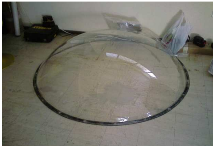
Foto 10. Colocación del sello alrededor del domo
