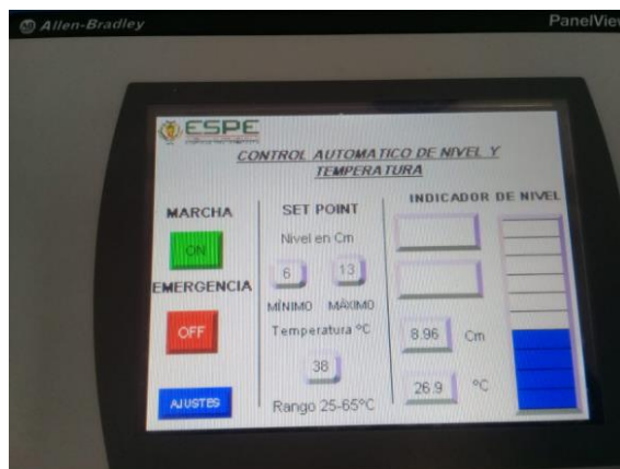
Figura 62 Puesta en marcha el sistema y encendido de la bomba
