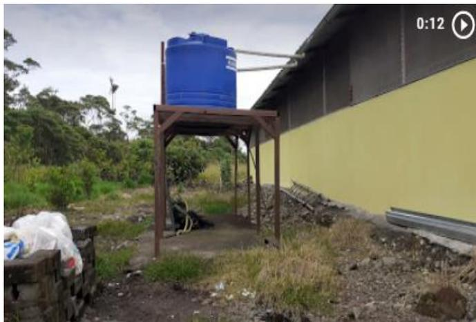
*Nota.* Se observa los tanques de agua de 2500L cada uno elevados a 2.5m de altura conteniendo agua del río situado posterior al centro de acopio usado para el lavado de pitahaya.
