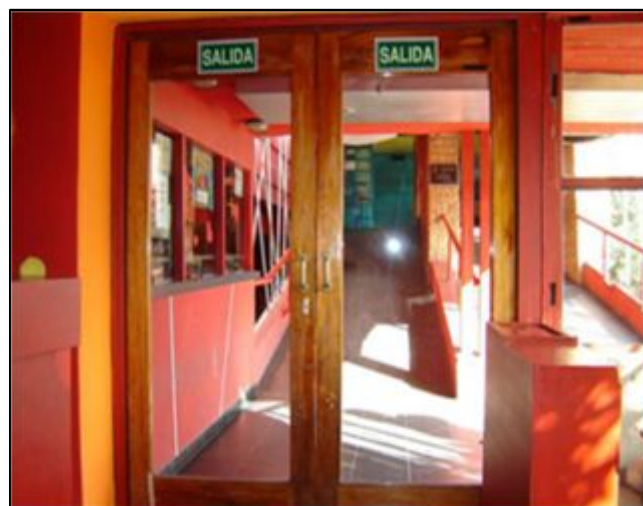
Figura 14 Puertas salidas de emergencia de vidrio templado Fuente (Paniagua, 2015)
