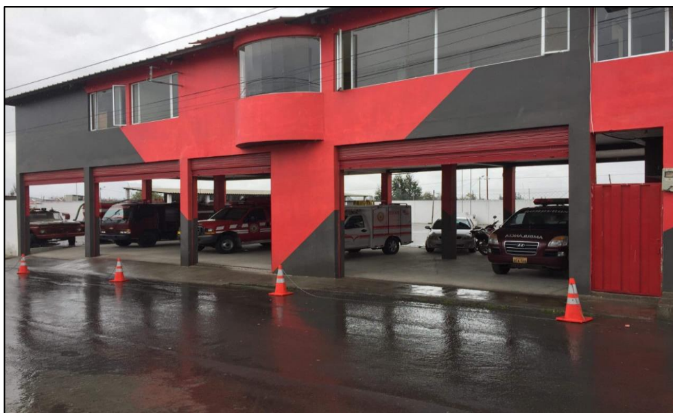
Figura 44 Fachada principal del Cuerpo de Bomberos del cantón Pujilí
