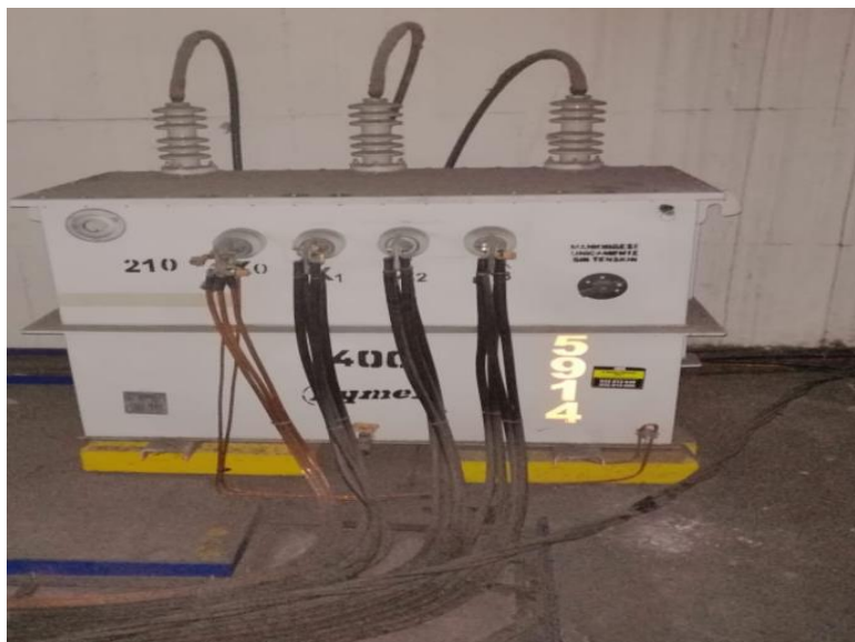
Figura 9. Salas de transformadores subterráneas
