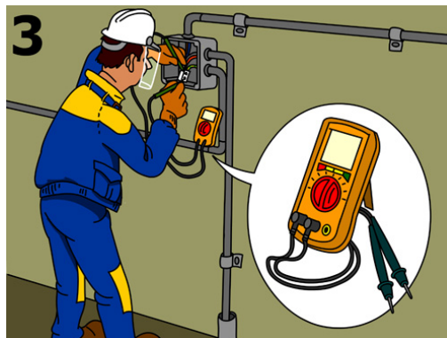
Figura 17. Verificar la ausencia de tensión
