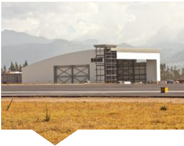
Hangar de mantenimiento
