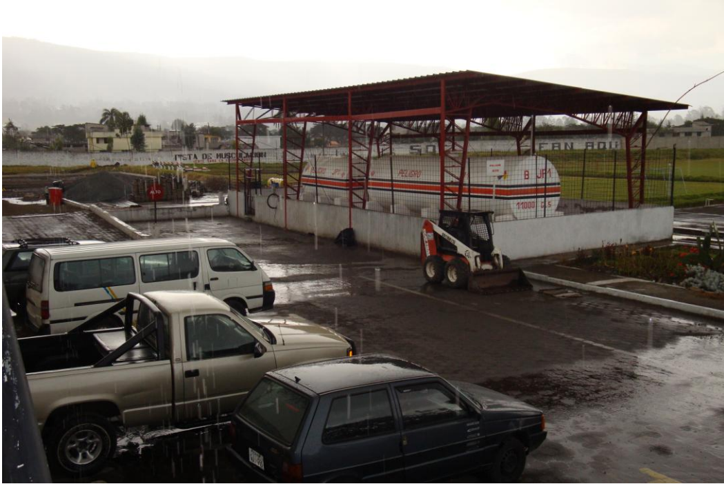
Figura 5 En esta figura podemos observar varios vehículos estacionados en el área de almacenaje del combustible lo que estaría atentando contra la seguridad.
