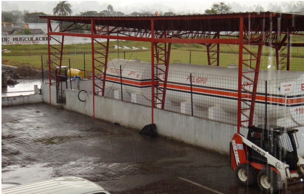
Figura 3 En esta figura podemos observar de mejor manera la cubierta del reservorio, adicional se puede visualizar que no existe ningún extintor contra incendios.
