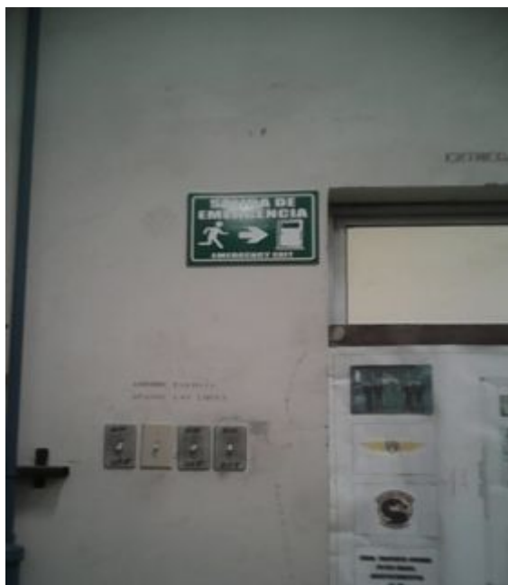
FIGURA N° 25 Salida de emergencia
