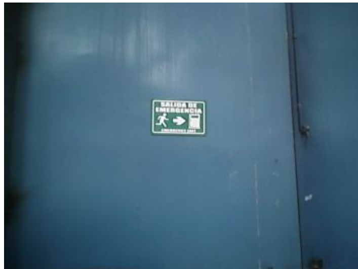
FIGURA N° 23 Puerta principal de salida
