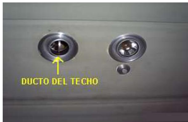
**Fig. 1.31 Ducto de salida del Techo.**
