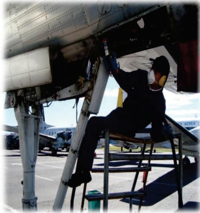
**Figura:** 4.9 Desconexión de la línea de vaciado de combustible
