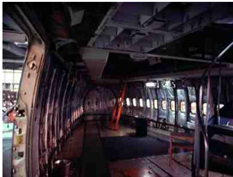
Fig. 3.28 estructura interior del avión Boeing 727
