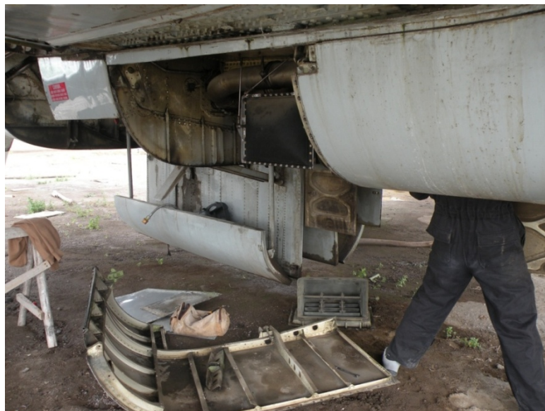
Fig.3.11 Desmontaje de puertas inferiores
