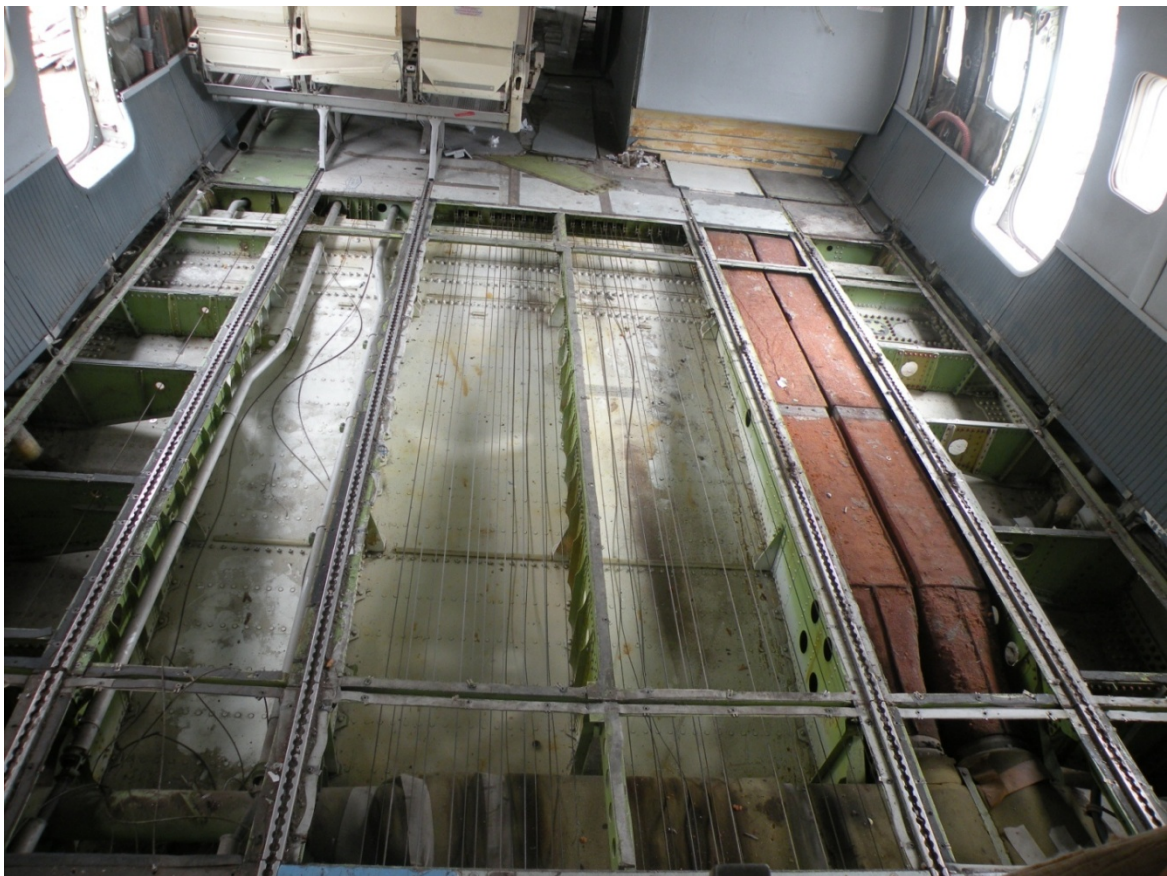
Fig. 3.5 Remoción del piso interior Boeing 727
