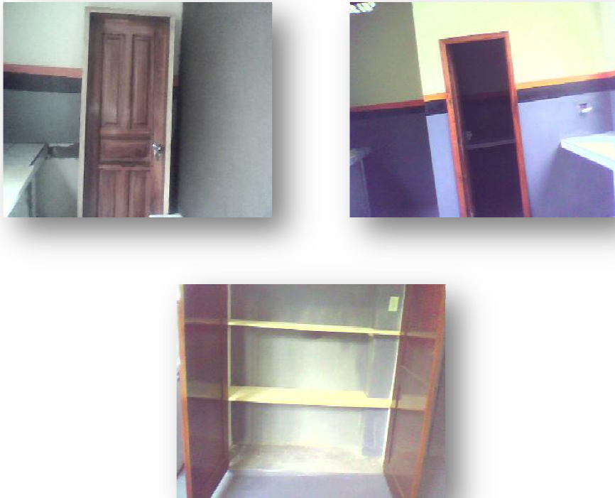
Figura 3.9 Instalación de puertas del cuarto oscuro y armario.
