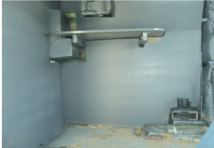
Figura 3.14. Pintado de paneles laterales
