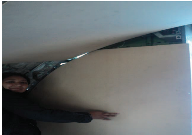
Figura 3.6. Instalación de los paneles de la parte de atrás.
