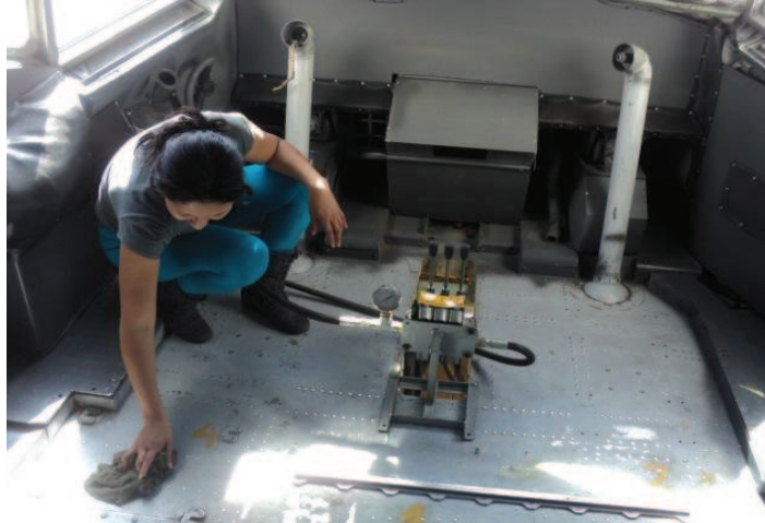
Figura 3.12. Limpieza de la cabina antes de la pintura
