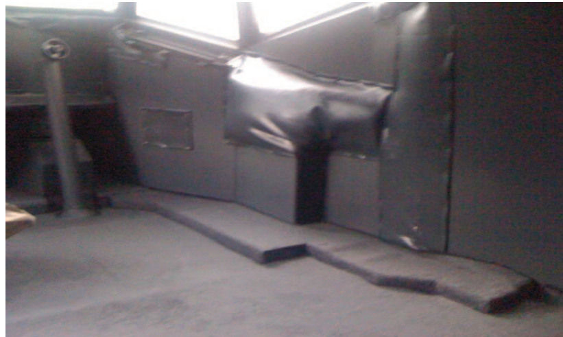
Figura3.30. Cabina casi terminada y alfombrada
