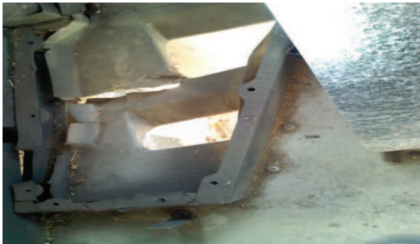
Figura 3.19. Sector de paneles especiales
