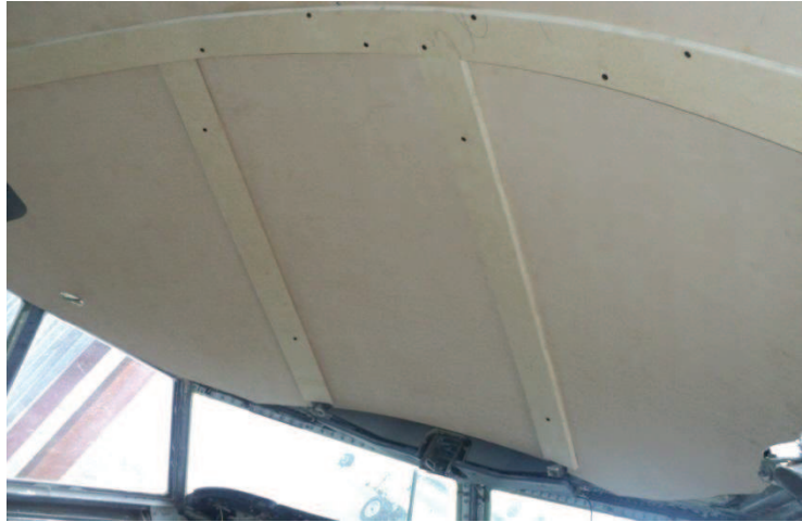
Figura 3.8. Instalación de los paneles de la parte de superior de la cabina
