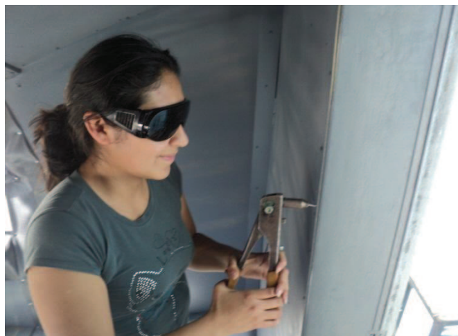
Figura 3.7. Asegurar los paneles.
