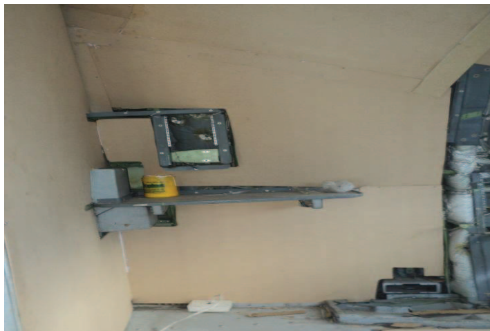
Figura 3.9. Instalación de los paneles de la parte de inferior de la cabina
