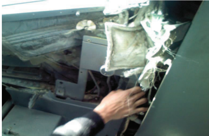
Figura 3.3. Retiro de partes inservibles de la cabina
