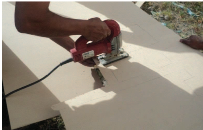
Figura 3.4. Corte de los paneles.
