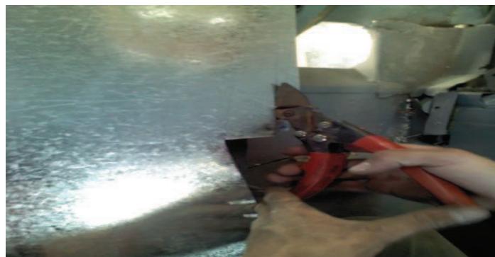
Figura 2.28. Corte para reparar el piso
