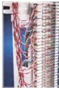
Figura D.2 Cables Ponchados
