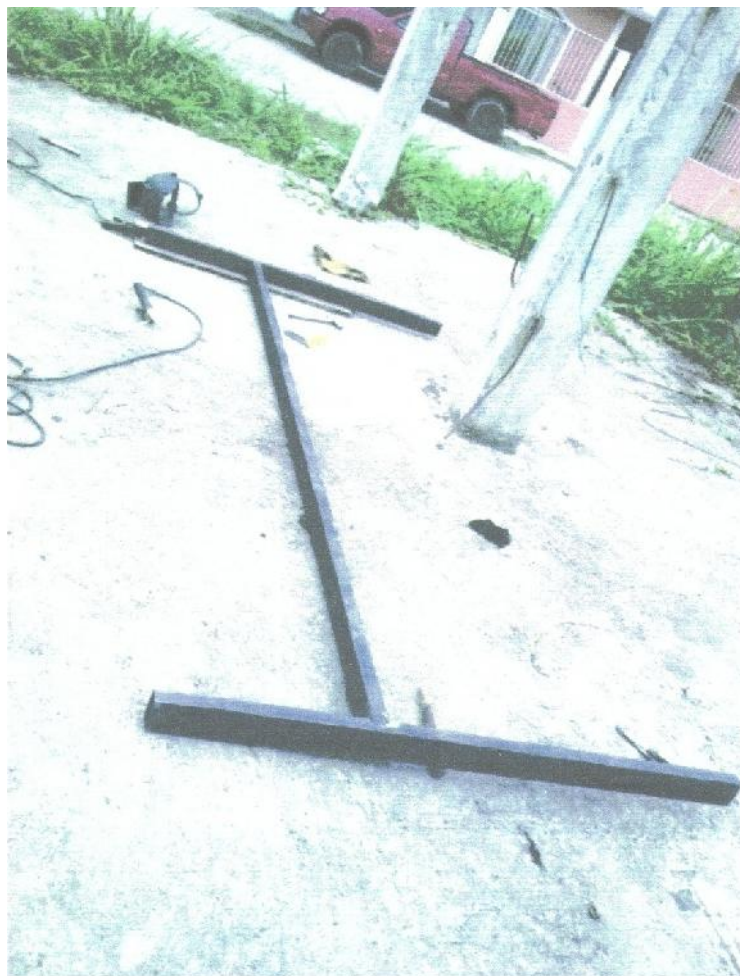
VIGAS DERECHAS SOLDADAS
