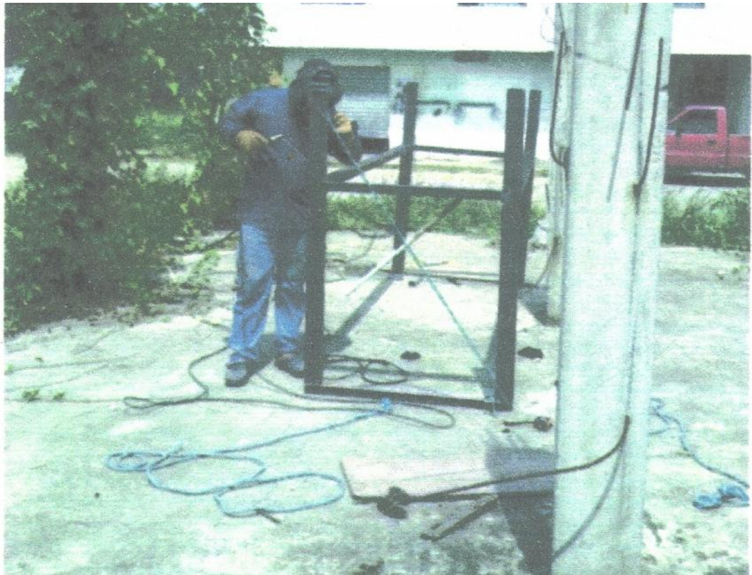
SOLDANDO LA PARTE BAJA DE LA PLATAFORMA
