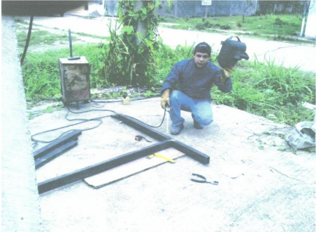
SOLDADURA DE VIGAS PRINCIPALES
