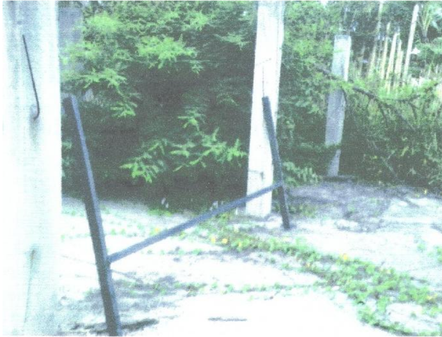
VIGAS IZQUIERDAS SOLDADAS
