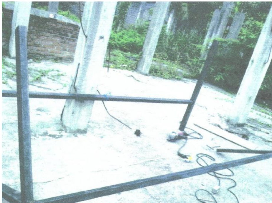
UNIÓN DE VIGAS DERECHAS E IZQUIERDAS
