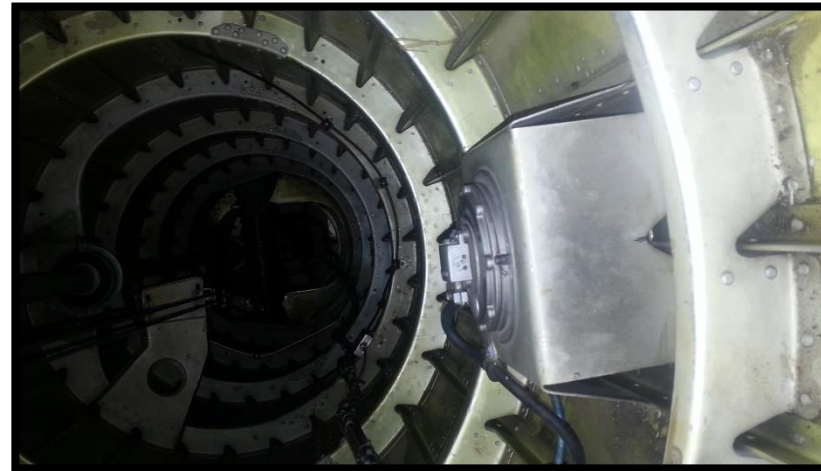
Colocación de las tuercas del eje del estabilizador horizontal
