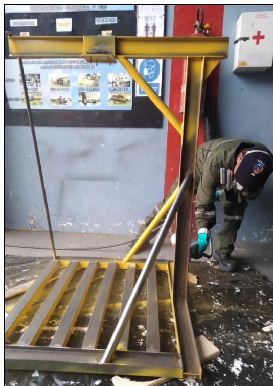
Aplicación del recubrimiento orgánico
