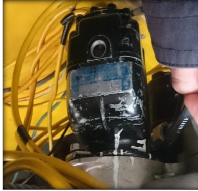
Figura : Instalación de magnetos
