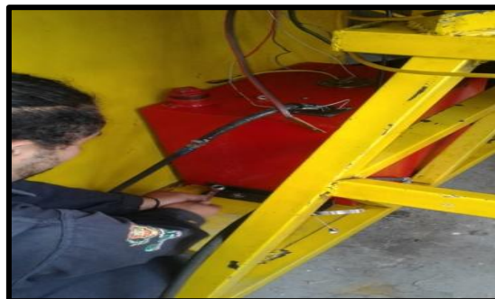
Figura : Instalación del tanque de combustible
