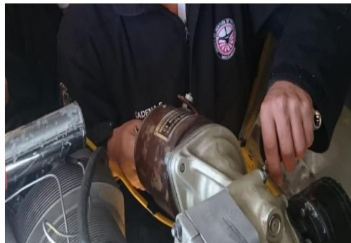
Figura Desinstalación del arranque del motor
