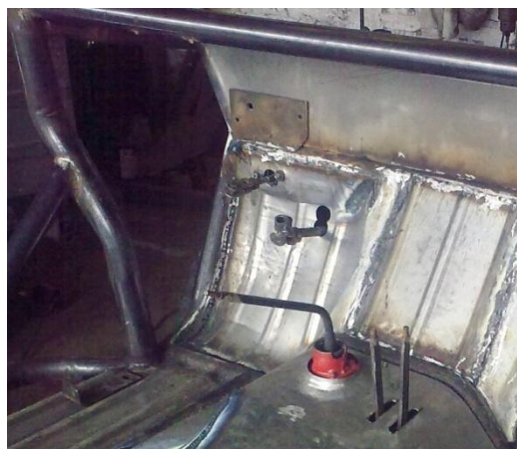
Figura 4.11 Agujero para instalación de la barra de la dirección.
