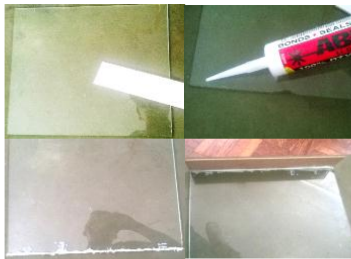
Figura 22 Construcción de la cámara de pruebas.
