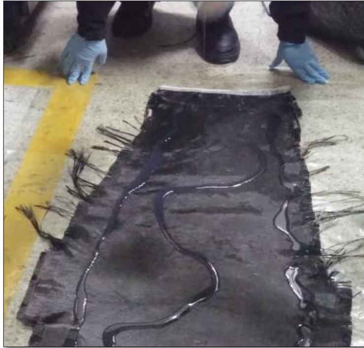
Figura 30 Empastado con resina
