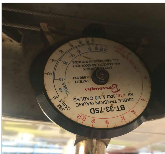
Figura 49 Verificación de la tensión
