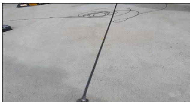
Figura 34 Inspección visual de los cables
