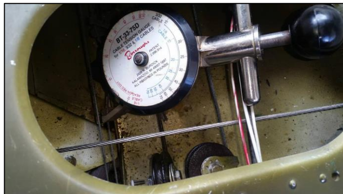
Figura 60 Verificación de la tensión
