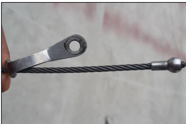
Figura 39 Inspección de los terminales
