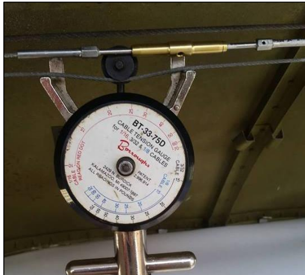
Figura 57 Verificación de la tensión
