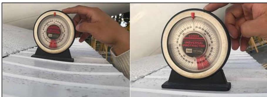
Figura 52 Verificación de inclinación de los alerones
