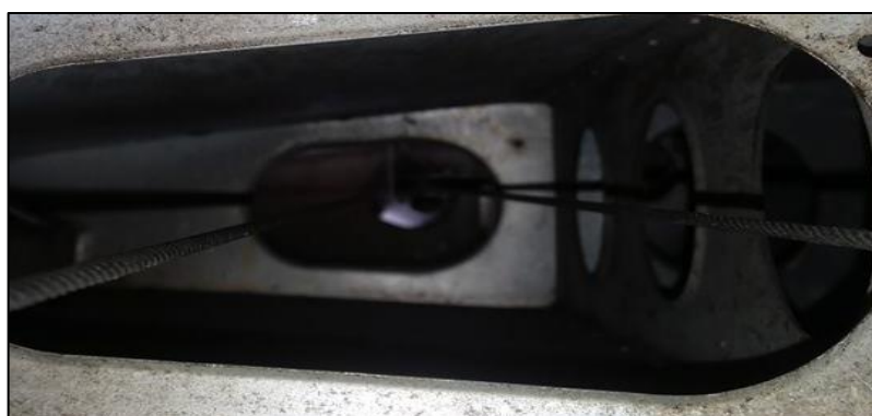
Figura 44 Verificación del tendido de los cables
