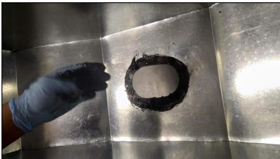
**Figura 58** Colocación de empaques y pegamento anti fugas.
