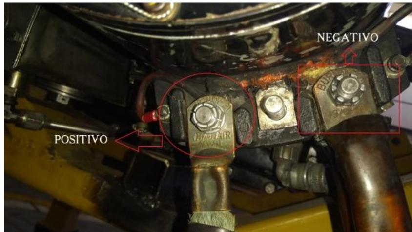
**Figura 72** Conexiones del generador
