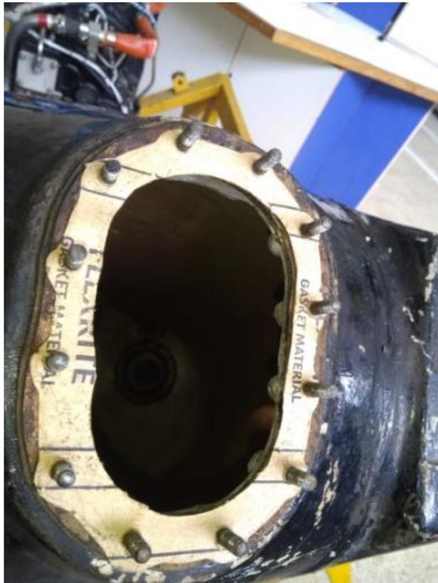
**Figura 48** Colocación de empaque nuevo
