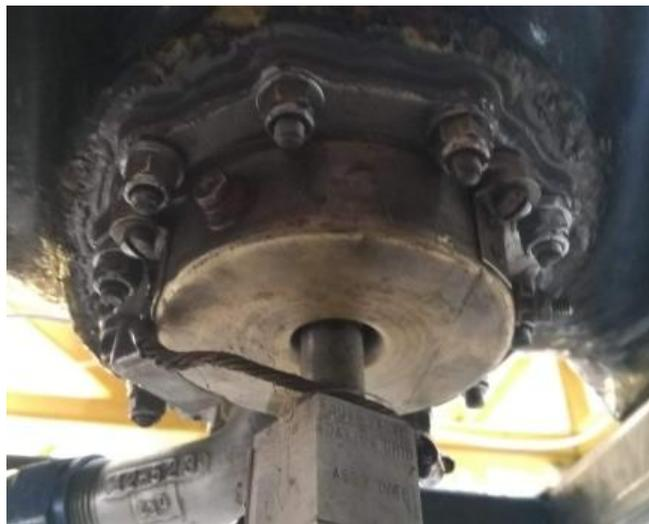
**Figura 53** Colocación de PRC - CS-3204 A.
