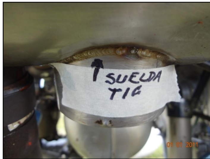
Figura 41. Cordón de Suelda
