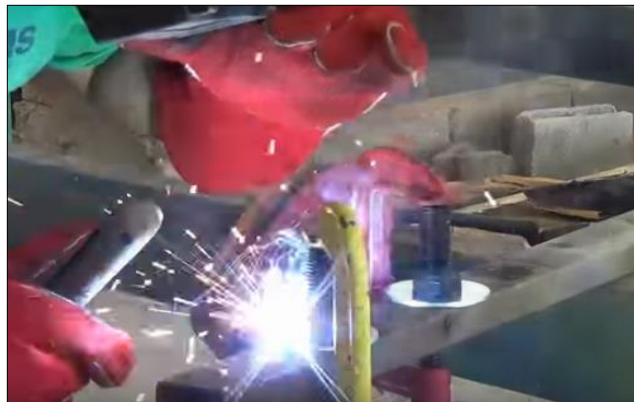
Figura 27 Proceso de soldadura
