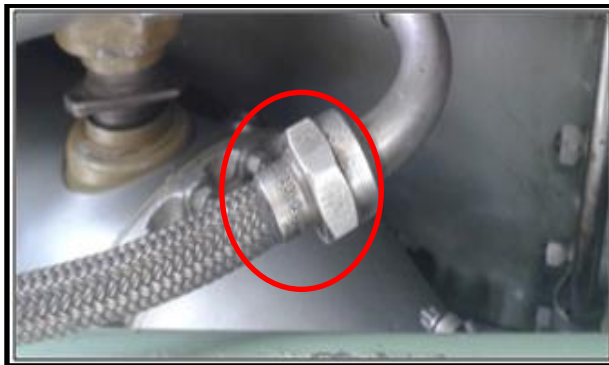
Figura 27 Junta soldada conexión externa/revestimiento metálico
