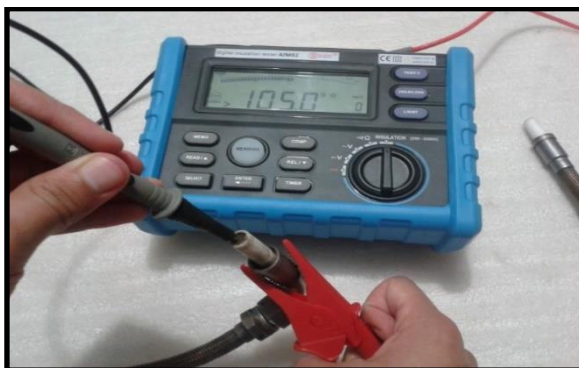
Figura 40 Comprobación de resistencia de aislamiento del cable de HT
