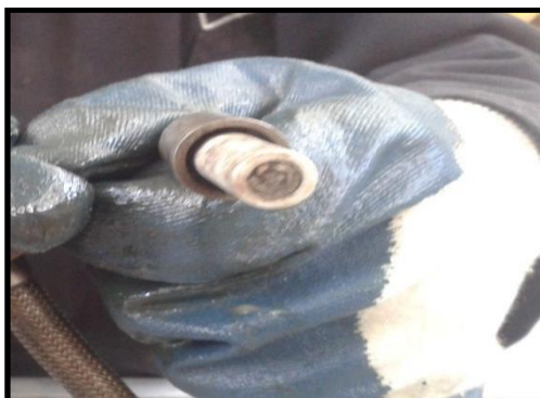
Figura 38 Aisladores del cable
