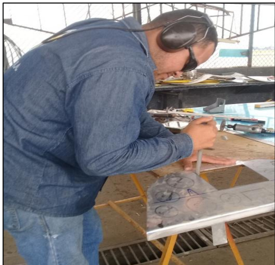
Figura 41 Pulida del corte para el GPS
