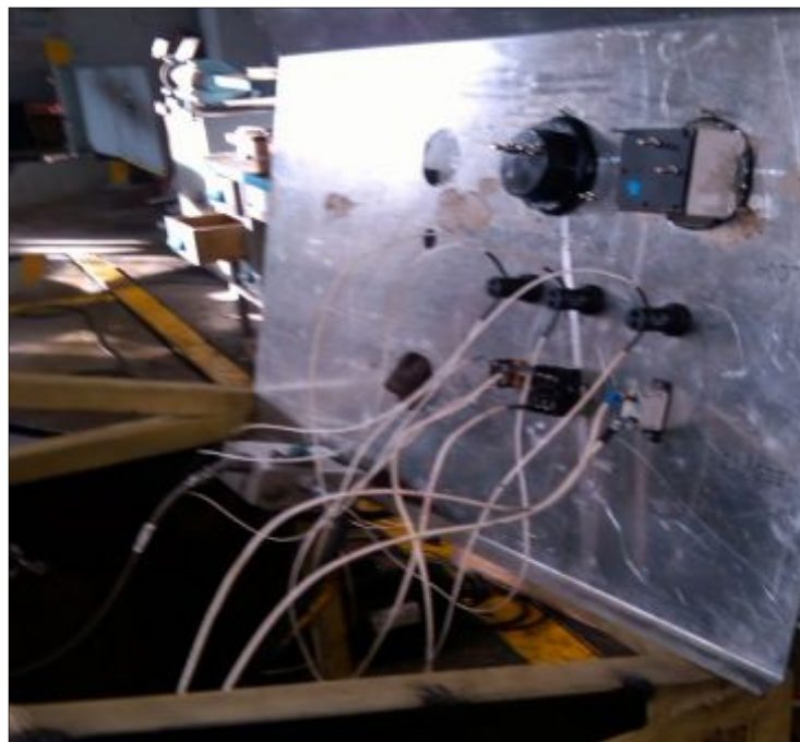
Figura 52 Instalación del panel de control
