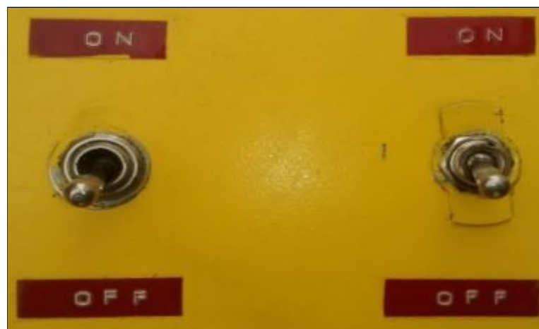
Figura 70 Interruptores en apagados
