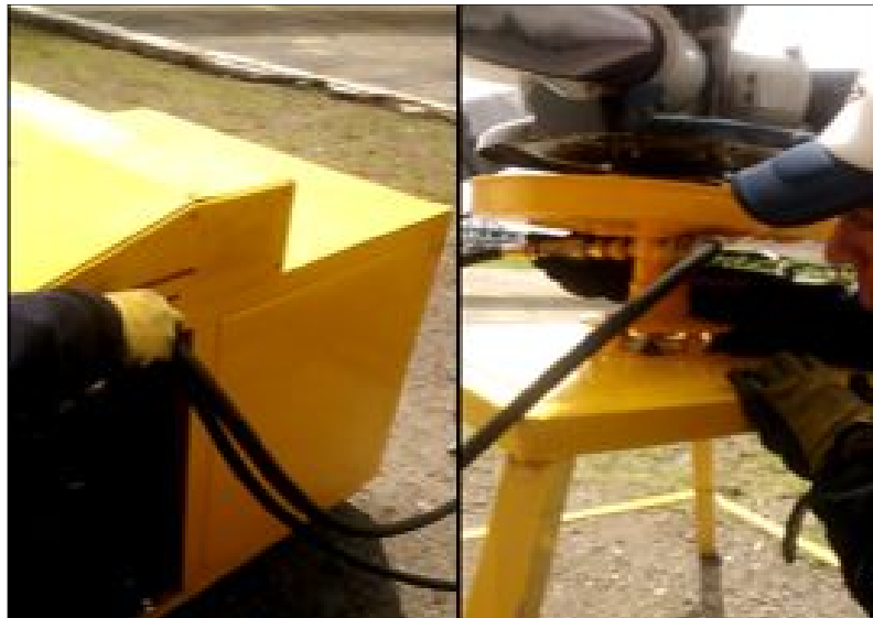
Figura 63 Verificando cañerías de presión y retorno
