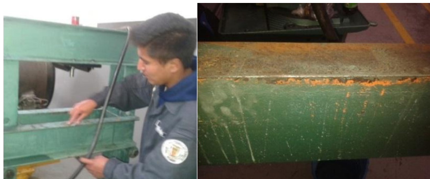
Figura 43 Remoción de la presencia de corrosión de la estructura
