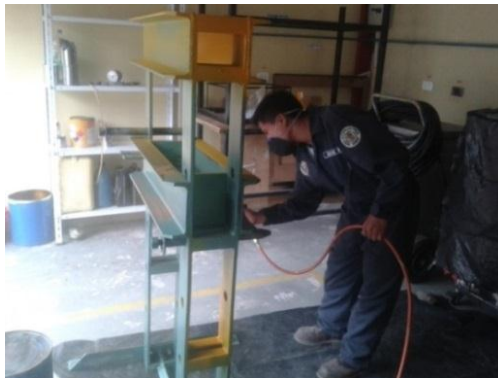
Figura 44 Pintado de las zonas de difícil acceso de la estructura
