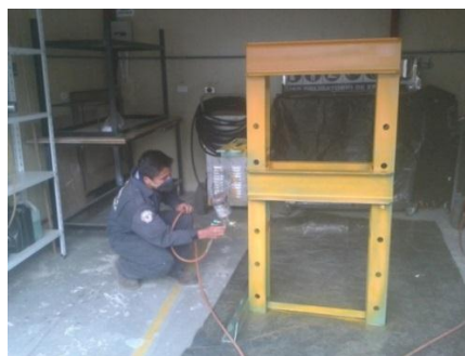
Figura 45 Pintado de la primera capa de pintura
