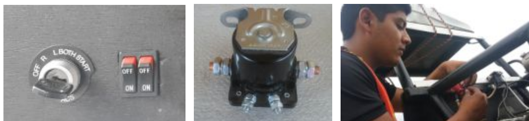
Figura 91 Instalación del sistema eléctrico.
