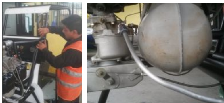
Figura 79 Instalación del sistema de combustible.
