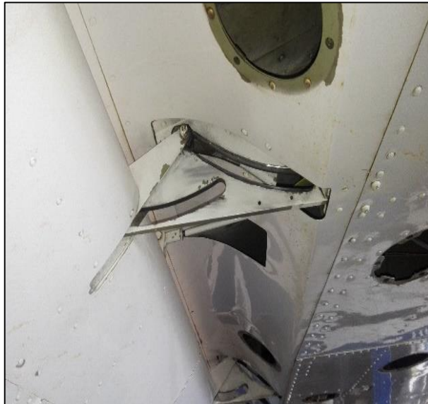
Figura 96 Inspección Visual de los Rodillos de los Flaps.
