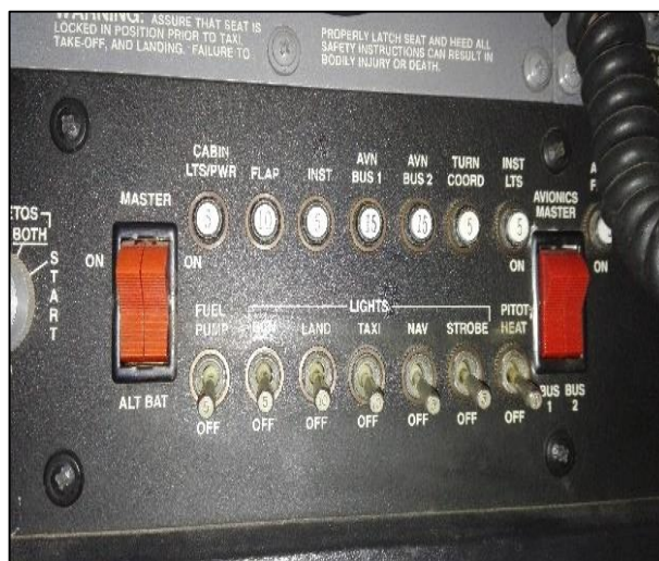
Figura 74 Panel de cortacircuitos e interruptores.
