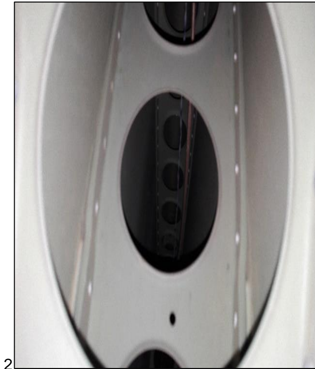
Figura 88 Inspección Interna del Estabilizador Horizontal.
