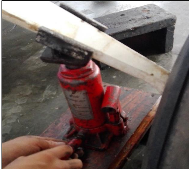
Figura 127 Colocación de la Gata.
