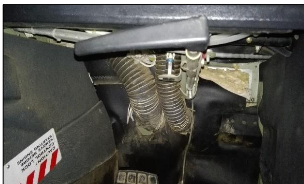
Figura 77 Inspección Visual Bloqueo de control de la Rueda.
