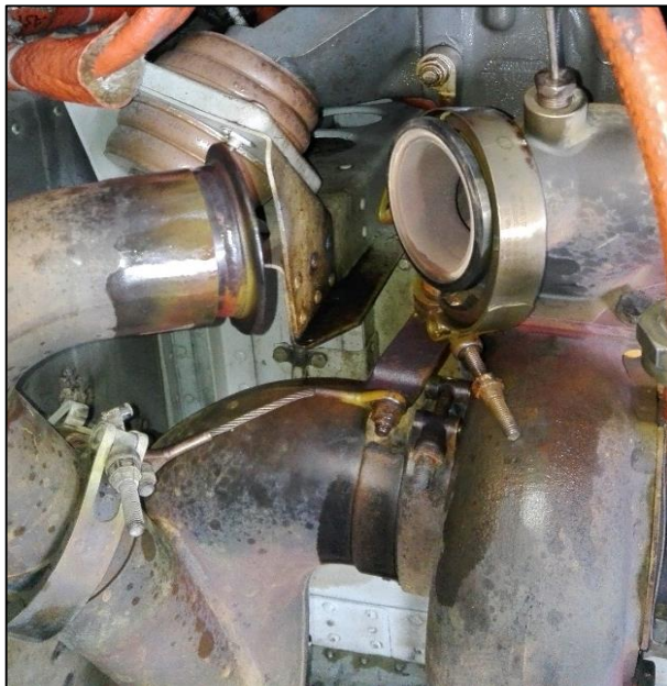
Figura 51 Inspección de las Abrazaderas.
