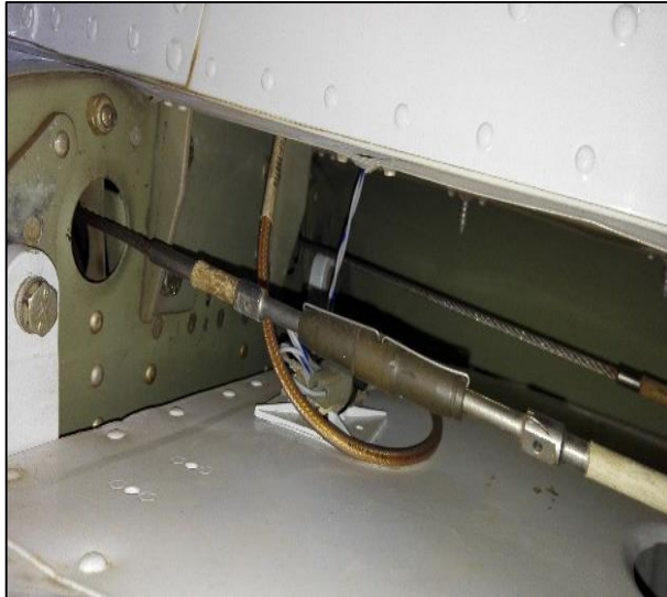
Figura 90 Inspección Visual del Turnbuckle del Rudder.
