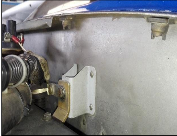
Figura 105 Inspección Visual de la Pared de Fuego.
