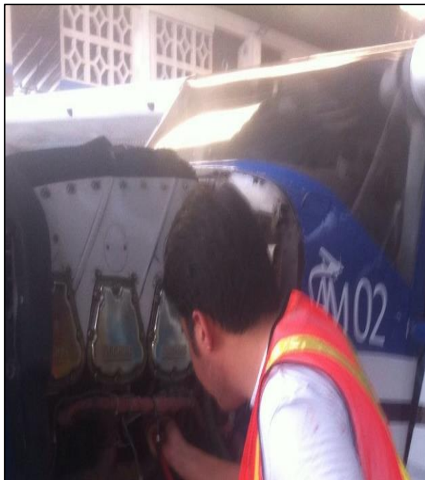
Figura 49 Inspección De Los Deflectores Del Motor Y Las Juntas.
