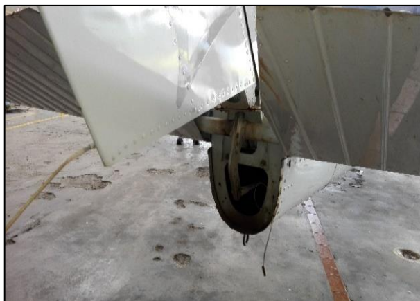
Figura 80 Inspección de los cables de control de Elevador.
