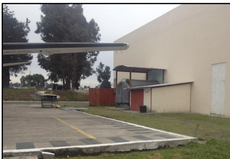
Figura 48 Vista lateral de la cabina
