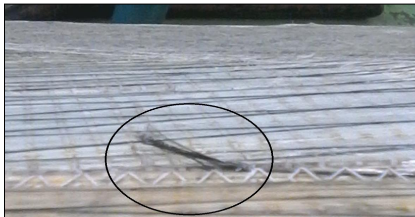
Figura 72 Nylon Roto En El Estrados Del Ala.
