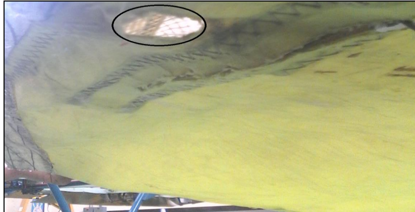
Figura 71 Ruptura En El Intrados Del Ala.
