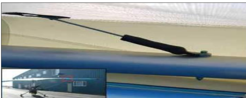
Figura 15 Vista Interior Del Ala.
