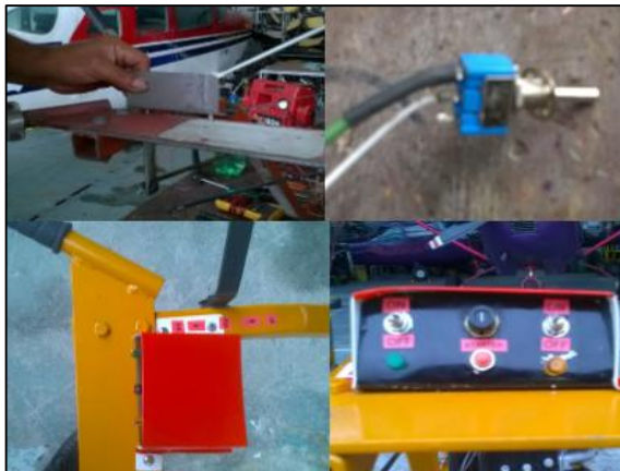
Figura 62 Colocación de un soporte para los interruptores.
