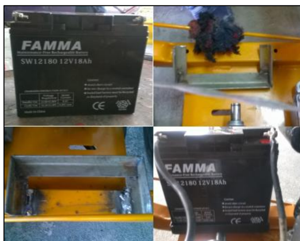
Figura 61 Construcción de un soporte para la batería.
