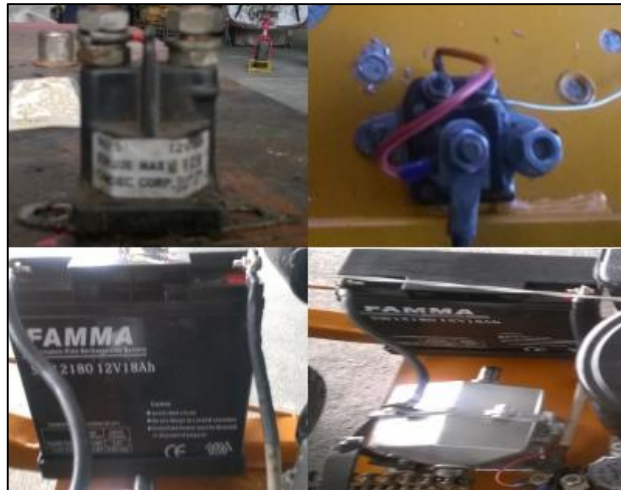
Figura 63 Montaje del contactor y batería de 12 V.
