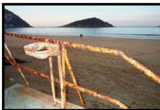
Figura 1.20 Oxidación de tuberías
