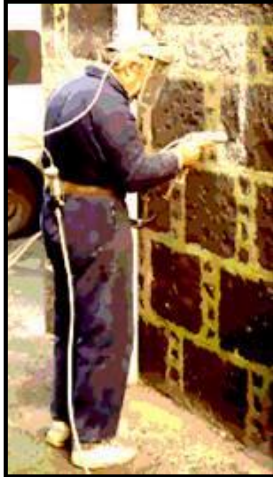
Figura 1.14 Sandblasting sobre la superficie de una pared
