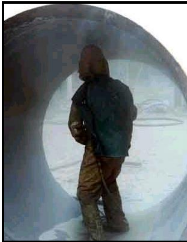
Figura 1.3 Aplicación del procedimiento Sandblasting sobre una tubería
