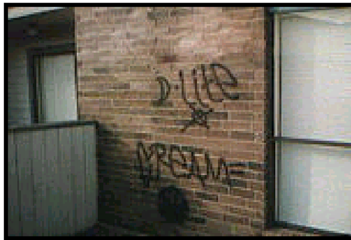
Figura 1.4 Pared antes del procedimiento Sandblasting
