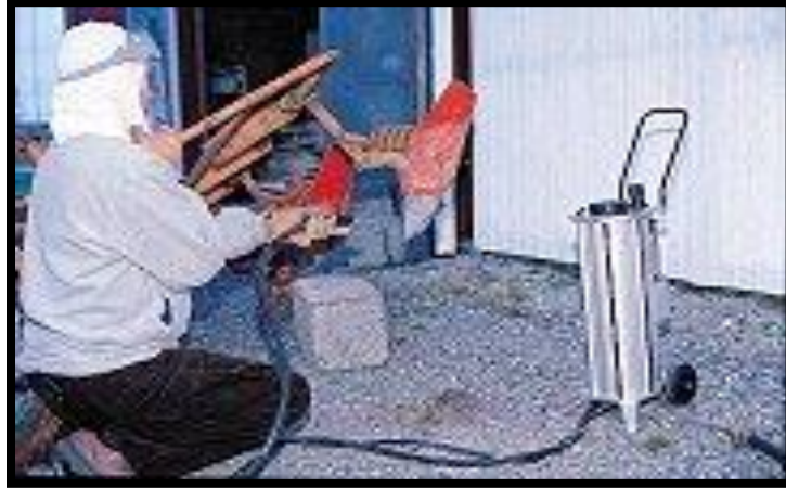
Figura 1.18 Remoción de pintura utilizando Sandblasting
