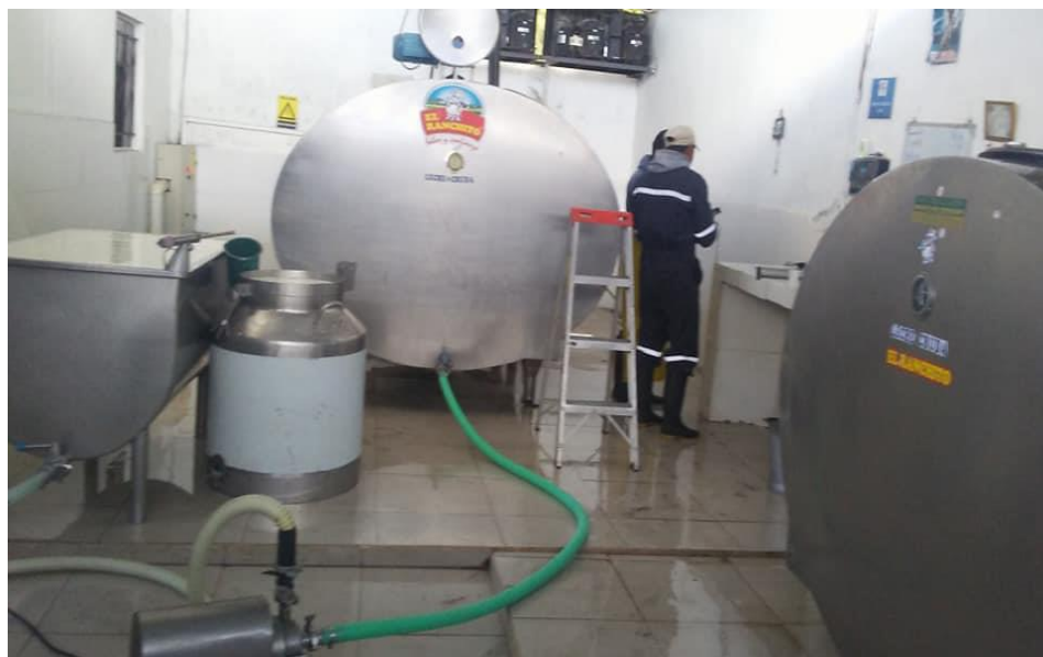
Figura 9 Clasificación de los tanques según su función
