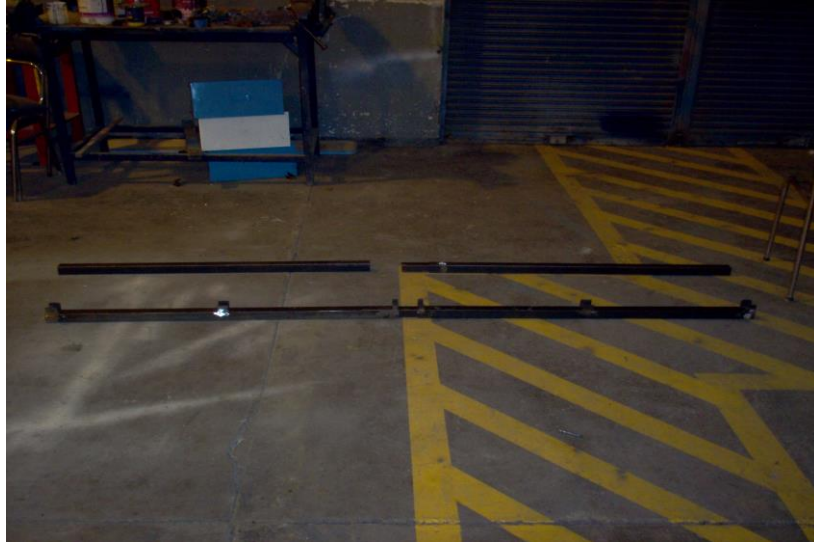
Figura 3.15 Unión de tubos de 2.40 metros
